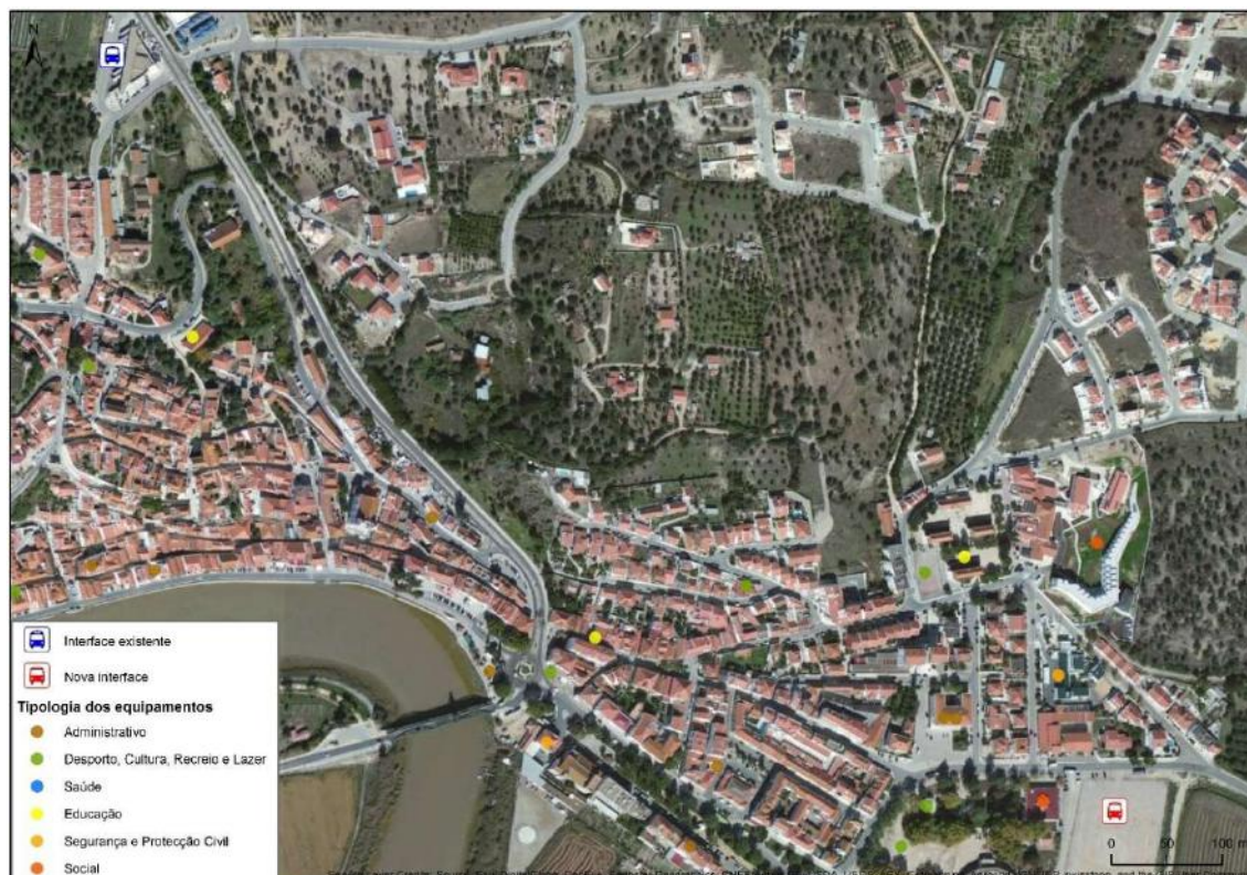
FIGURA 2.26 – LOCALIZAÇÃO DO TERMINAL RODOVIÁRIO DE ALCÁCER DO SAL E DA NOVA INTERFACE DE TRANSPORTES DA ZONA RIBEIRINHA NASCENTE
